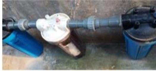
**Gambar 5.** Perangkat Filter air sungai yang terdiri filter sedimen dan filter Karbon
