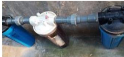
Gambar 5. Perangkat Filter air sungai yang terdiri filter sedimen dan filter Karbon
